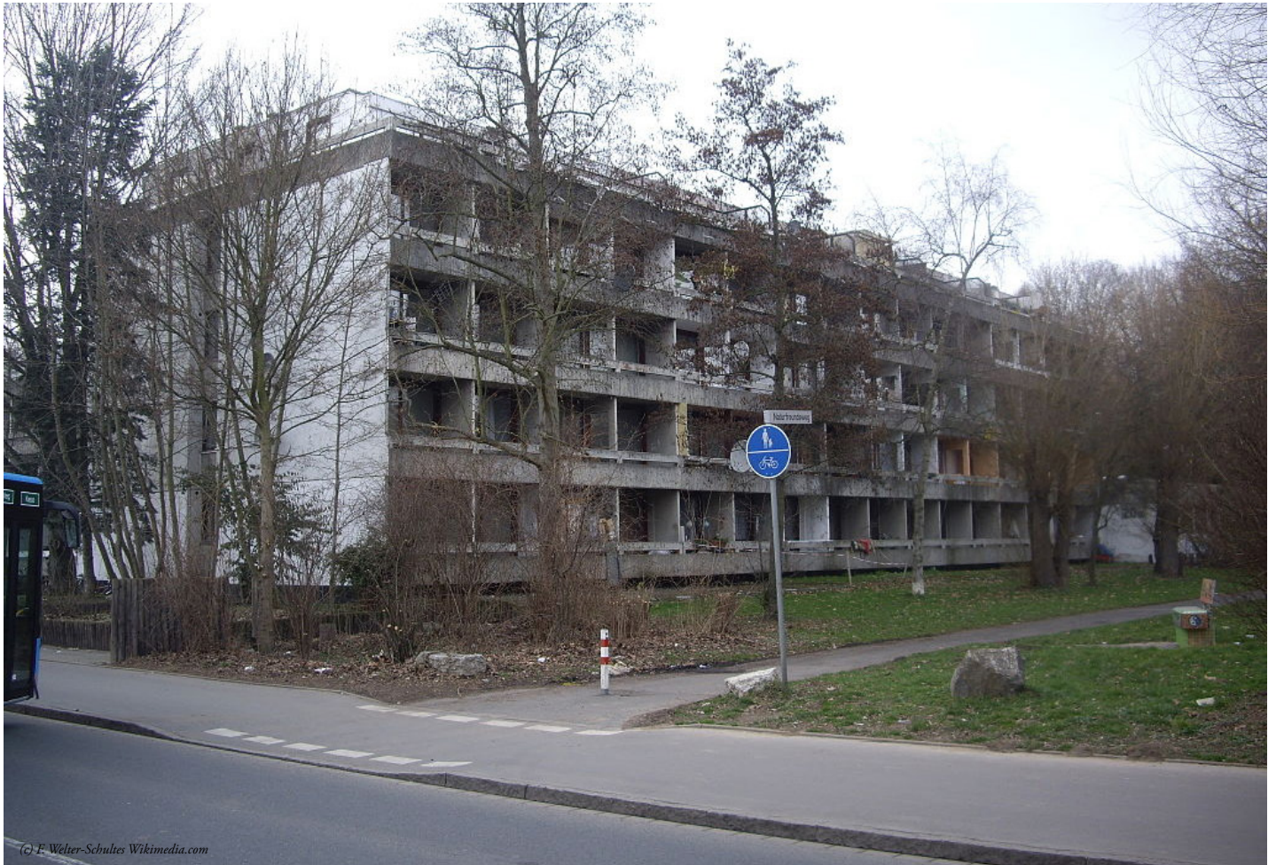
Über § 177 BBauG und Wohnungsaufsichtsgesetze haben Gemeinden ausreichend Möglichkeiten auf Eigentümer einzuwirken. Im Bild: Die Problemimmobilie Hagenweg 20 in Göttingen.
